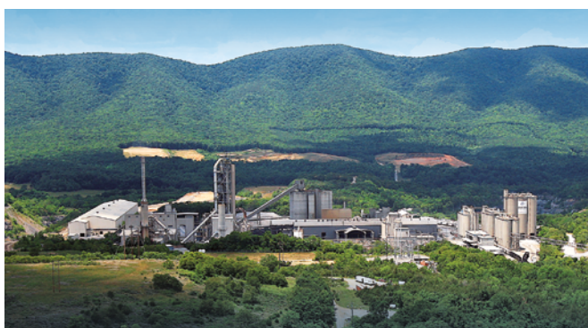
Εργοστάσιο τσιμέντου Roanoke, ΗΠΑ
