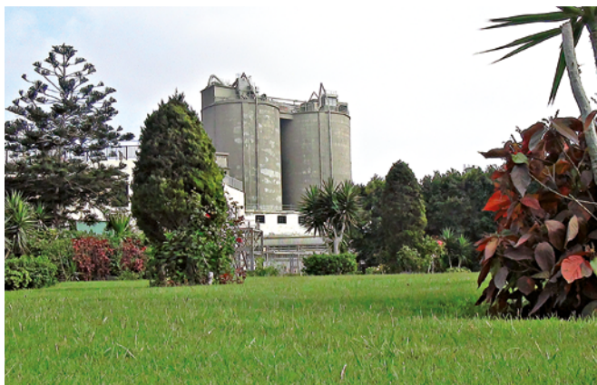
Εργοστάσιο τσιμέντου Alexandria, Αίγυπτος
