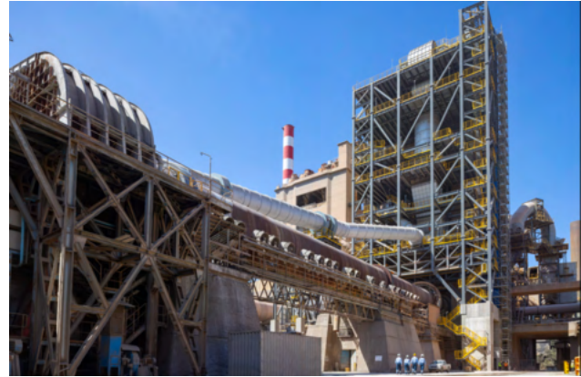
Précalcinateur de la cimenterie de Kamari, Grèce
