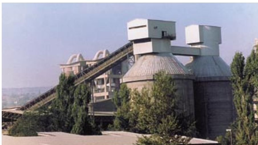
Usje plant, F.Y.R.o.Macedonia
