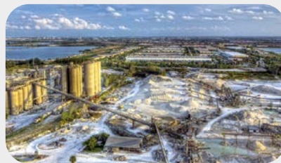
Cimenterie de Pennsuco, États-Unis
