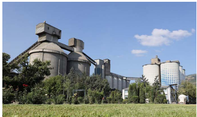
Usje cement plant, N. Macedonia
